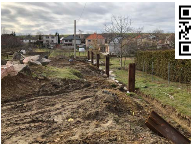
Stavba oporného múru
