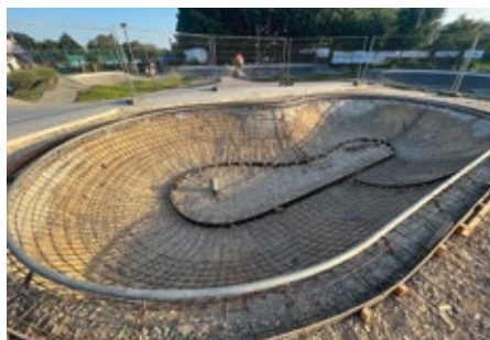
Stavba skateboardingového bazénu
